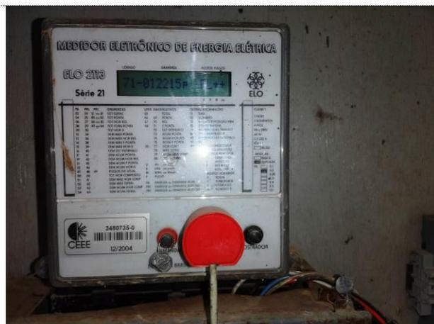
Foto 28 – Medidor de energia elétrica da bomba de captação.
